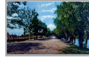
AVENIDA DE LOS LIBERTADORES 1912
