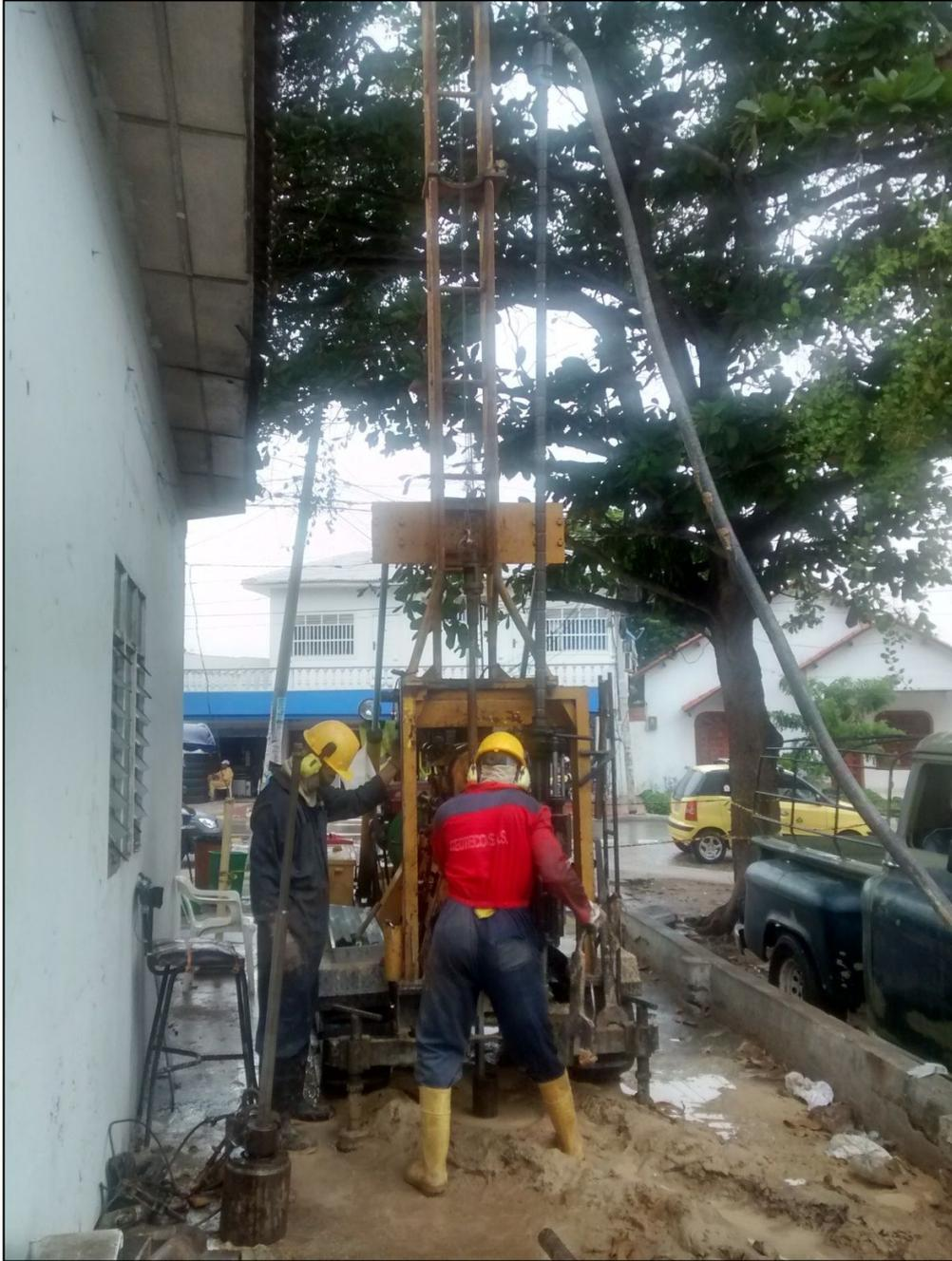
**Ejecución de sondeo SR-2 para toma de muestras con equipos de rotación.**
